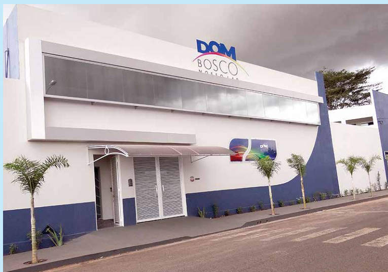
Fachada do Colégio Dom Bosco Nosso Lar
